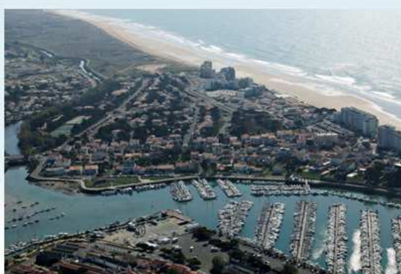
Saint-Gilles-Croix-de-Vie. Aménagements urbains.
