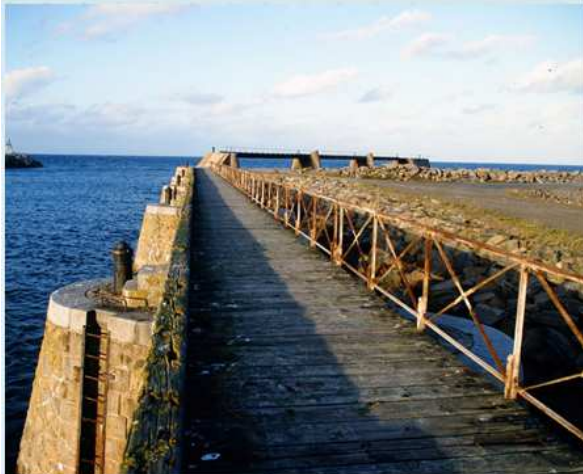
Yeu. Port-Joinville, brise-lames et passerelle de halage.
